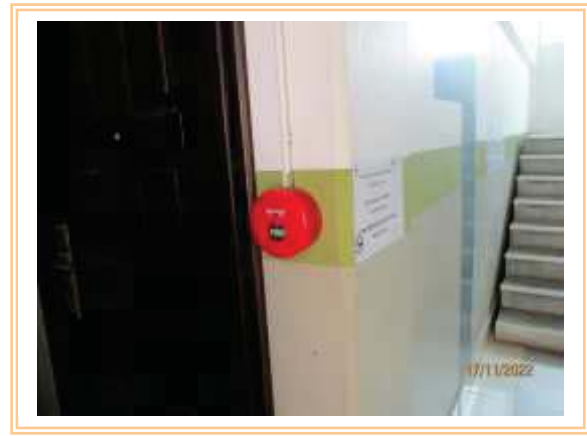
รูปที่ 2-5 Fire Alarm Bell
