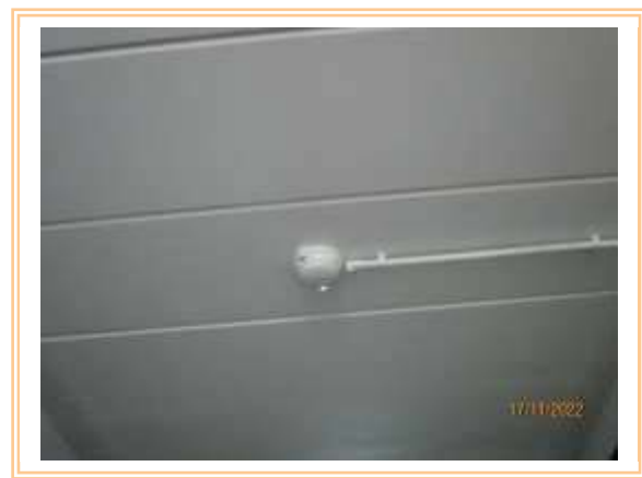
รูปที่ 2-7 Heat Detector
