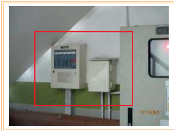
รูปที่ 2-4 Fire Alarm Control Panel
