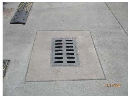
รูปที่ 3-21 ตะแกรงดักมูลฝอยบริเวณจุดระบายน้ำ
