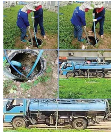
รูปที่ 3-19 สูดไขมันจากบ่อดักไขมันของระบบบำบัดน้ำเสีย
